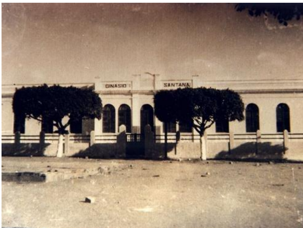
Ilustração 18 - Ginásio Santana, em registro fotográfico na década de 50.
