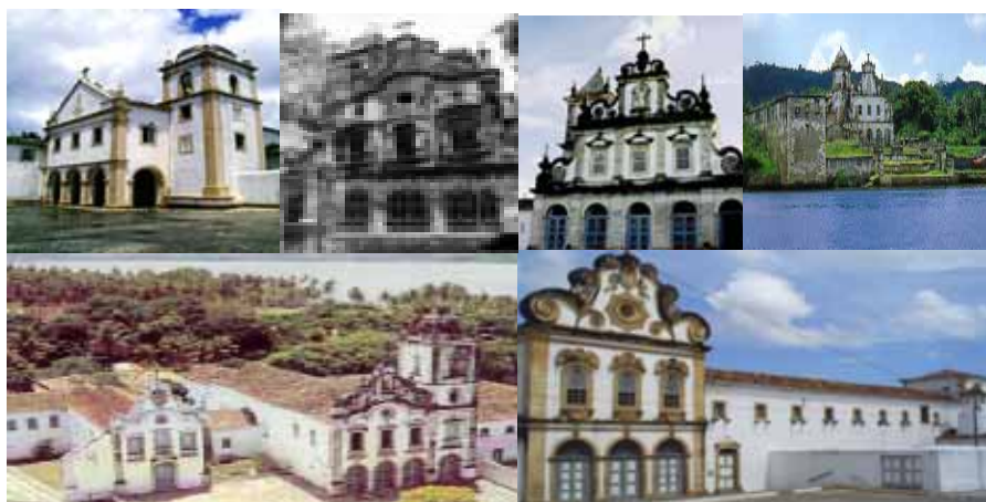
Figura 2 – Convento franciscano de Ipojuca/Pe (1606); Convento de S. Antônio, Recife/Pe (1606); Convento franciscano de Cairu/Pe (1650); Convento de Santo Antônio do Paraguaçu/Ba (1650); Convento de S. M. Madalena, antiga vila das Alagoas (atual Marechal Deodoro/Al) (1660); Convento de S. M. dos Anjos, Penedo/Al. Fonte: MAGALHÃES, 2005; EMATUR; Mônica Santos, 2006.
